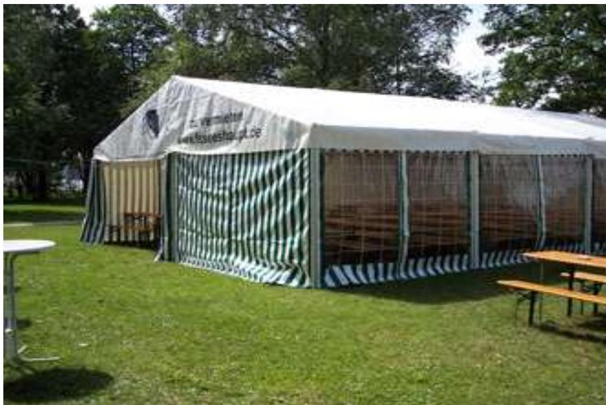
Das Zelt hat eine Breite von 8,0 m, eine Traufhöhe von 2,38 m, eine Firsthöhe von 3,68 m, einen Binderabstand von 3,0 m und eine maximale Länge von 30,0 m.
